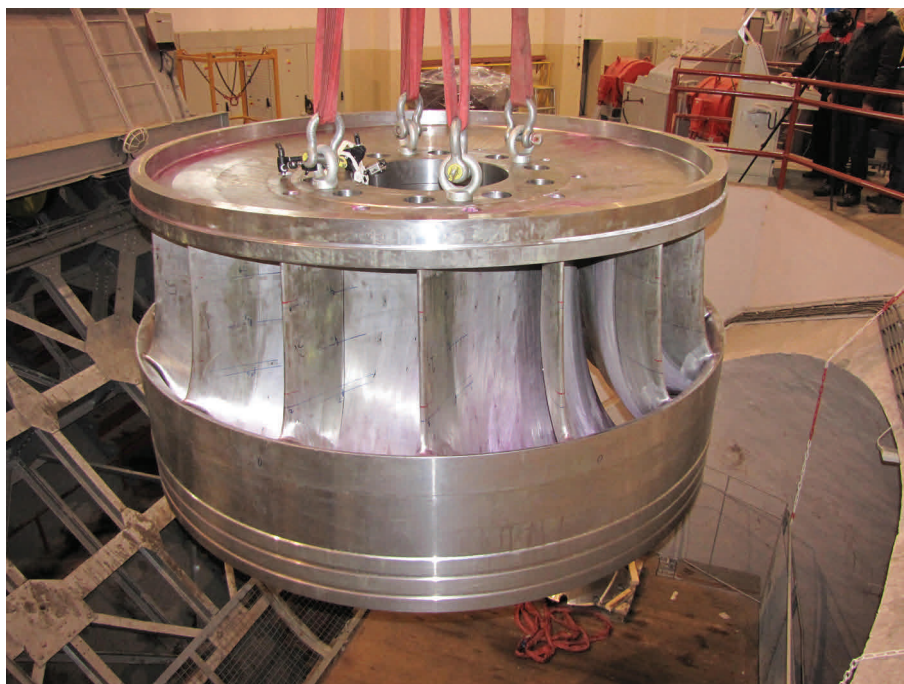
Instalace nového oběžného kola
